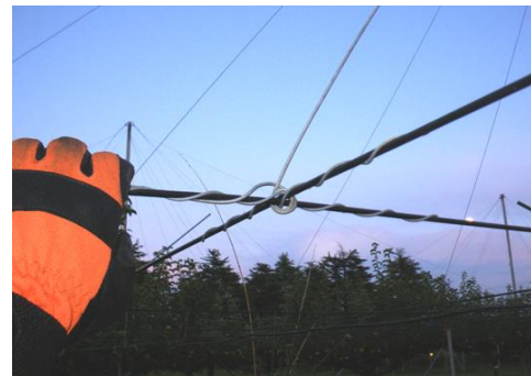
写真2 幹線の交差したところに中柱を入れる。線がずれないようにクリップが巻いてある。
